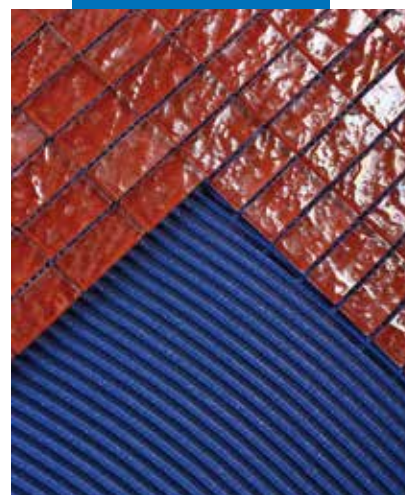
Následující den pokračujeme spárováním Kerapoxy Designu stejné barvy a stejným způsobem jak je dříve uvedeno
