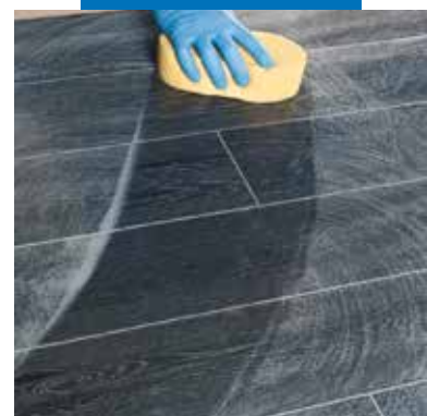
Čištění a dokončení povrchu spár tvrdou houbou z celulózy
