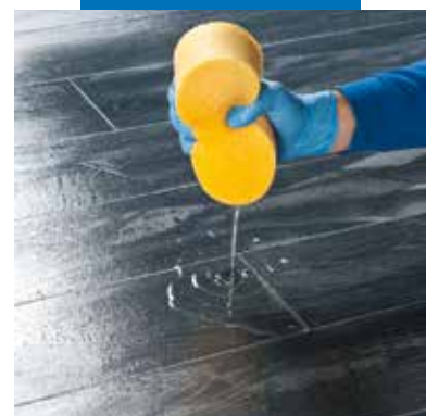
Navlhčení spárovaného povrchu před čištěním
